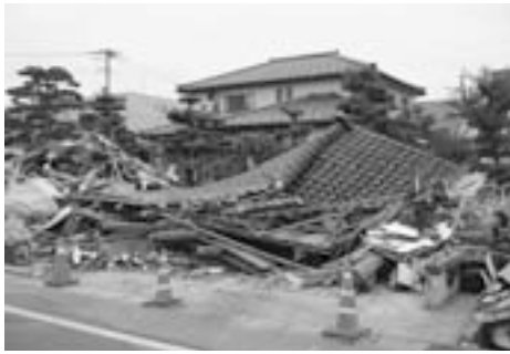
新潟県中越沖地震(2007年7月)での住宅被害
